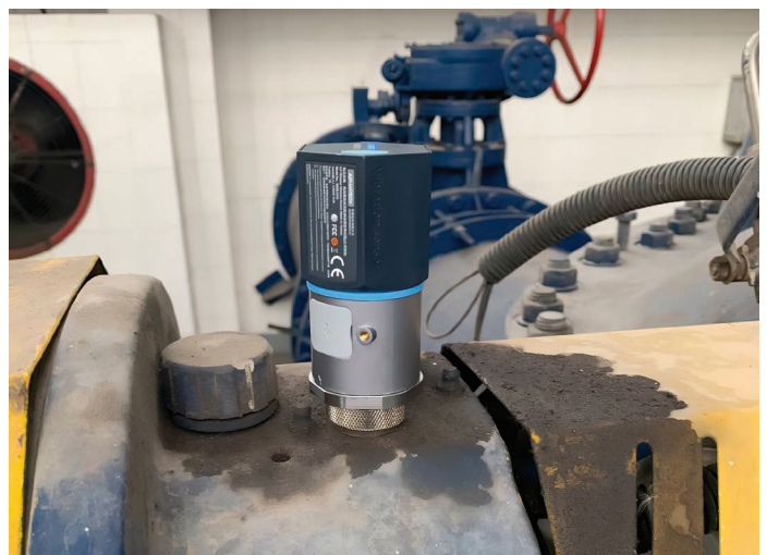
Bild 6: Ein LoRaWAN-IoT-Modul misst die Maschinenschwingungen eines Motors.
