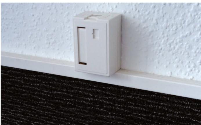
**Kleine Aufputz-Modulaufnahmen mit kurzen RJ45-Modulen benötigen nur wenig Platz und fallen kaum auf. Der Kabelabgang nach oben längs der Wand vermeidet Stolperfallen.**
